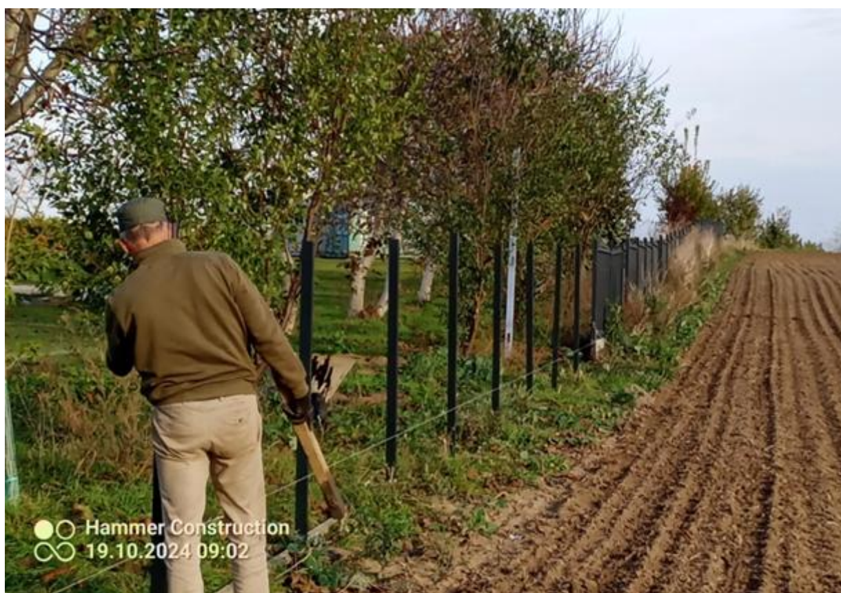
Budowa ogrodzenia boiska z konkursu grantowego Aktywni na Ziemi Średzkiej
